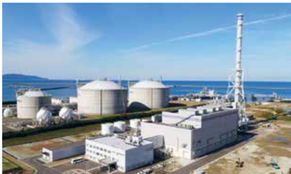
2022年12月に営業運転を開始した上越火力発電所
