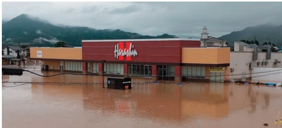
【店舗周辺一帯が水没した原信荒川店】
