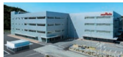
出雲村田製作所の新棟
