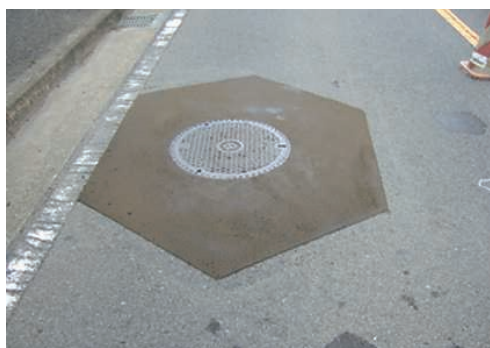
スーパーロメンパッチの施工例
