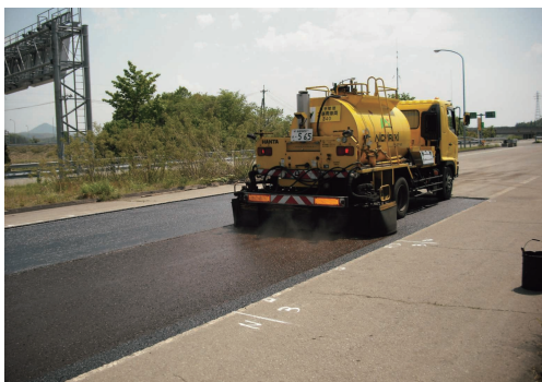
デストリビュータによるアスファルト乳剤の散布
