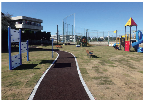
アスウッド工法（木材チップ舗装）
