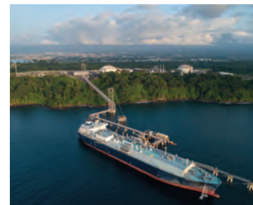
EG LNG project (Equatorial Guinea)
