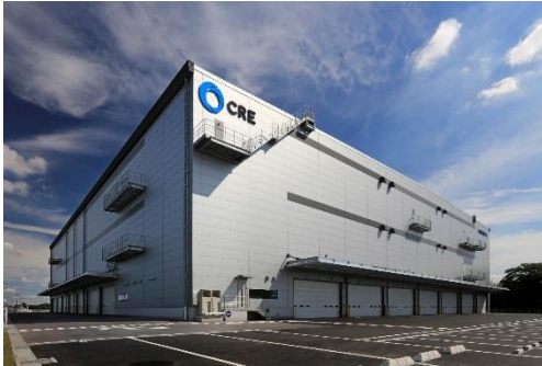
13 ロジスクエア春日部 2018年6月竣工
