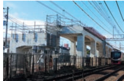
京王線連続立体交差事業
