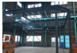
工事中の佐倉工場
