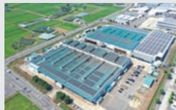
TPR工業に設置したソーラーパネル 発電量：Max1,553KW
