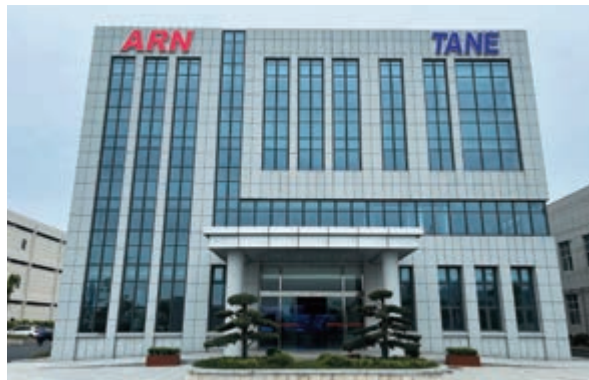
中国の研究開発拠点 TANE (TPR ARN (Anhui) New Energy R&D Co., Ltd.) 外観 2023年5月31日竣工 ※TANEは新エネルギー車 (New Energy Vehicle : NEV) およびCASEに対応する新技術・新製品の開発を担う
