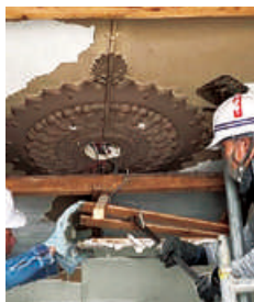
天井材の撤去により、隠れていた創建時の天井飾りが出現(左)。一時撤去して補修、補強した後に創建時の姿に復元された(右)
