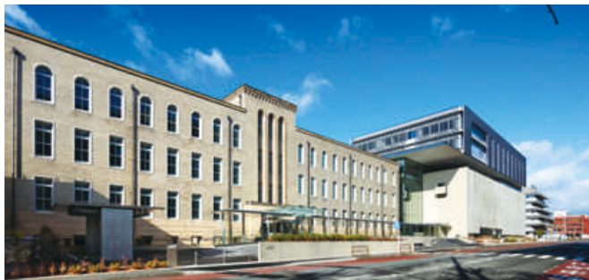
改修した旧京都府警察本部本館(手前)と増築した京都府庁3号館(奥)
