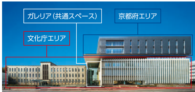
旧京都府警察本部本館(左)と京都府庁3号館(右)。高さを揃えて、外壁タイルを同系色にすることで一体性を演出
