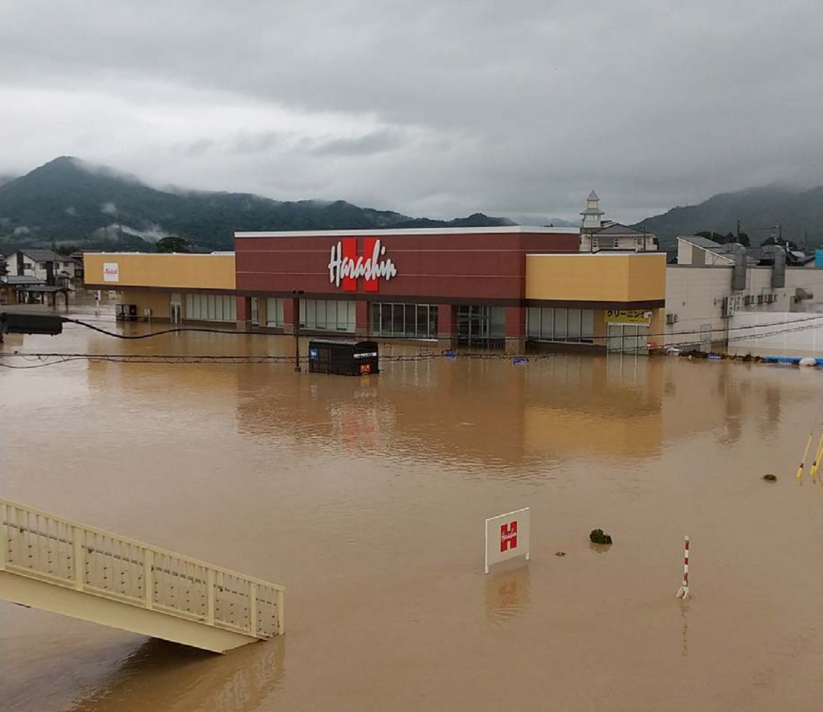
2022年8月新潟県県北豪雨 (原信荒川店)
