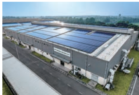
〈ベトナム工場設置の太陽光パネル〉
