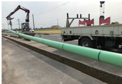
延伸工事の様子
