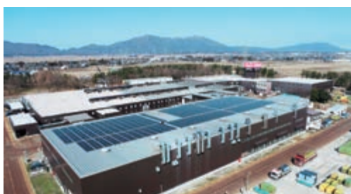
本社工場の屋上に設置した太陽光パネル
