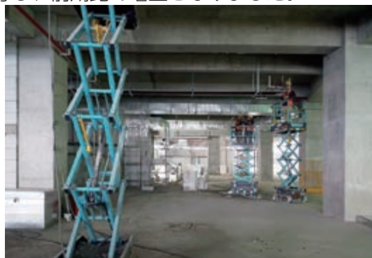
高所作業車 配線・配管作業現場 (中国)
