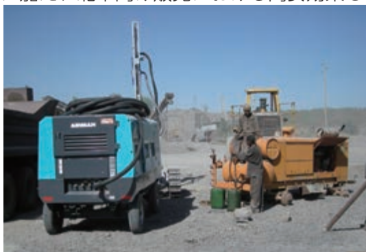
コンプレッサ 掘削工事現場 (アフリカ)
