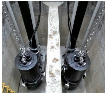
ポンプ据付状況
