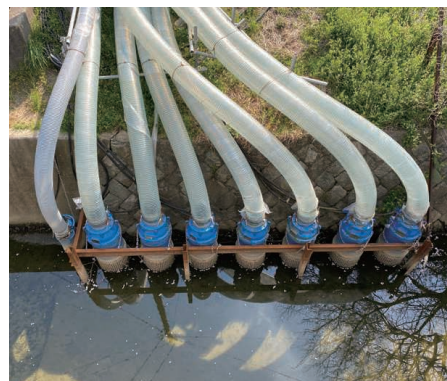
ポンプ据付状況
