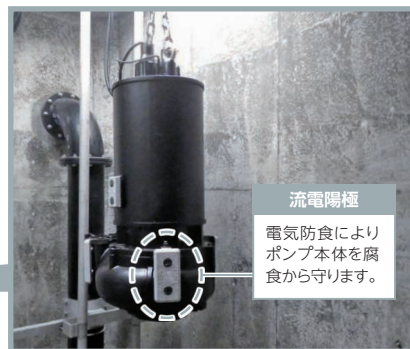
ポンプ据付状況
