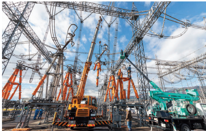
変電所開閉器交換工事（静岡県）
