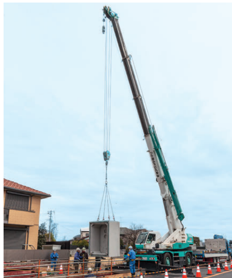
電力用マンホール設置工事（埼玉県）
