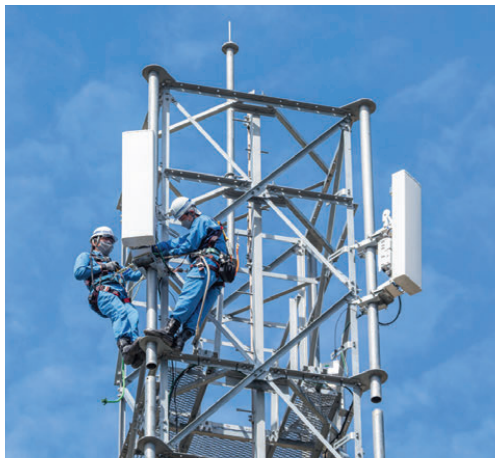
携帯電話基地局新設工事（千葉県）
