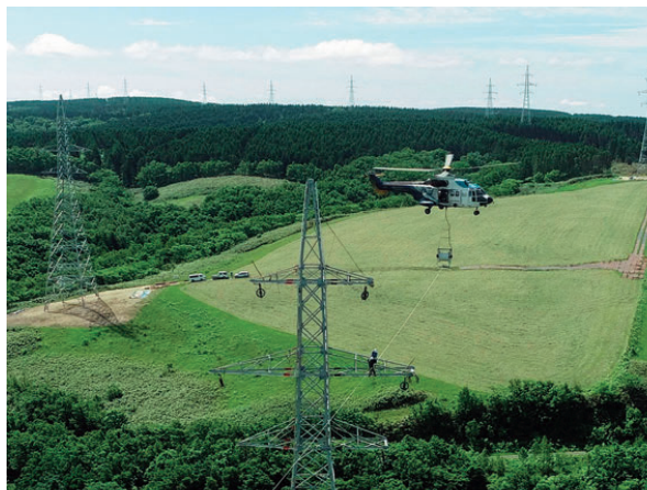
ヘリコプターを使用した延線作業
