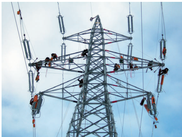
鉄塔上での碍子取り付け
