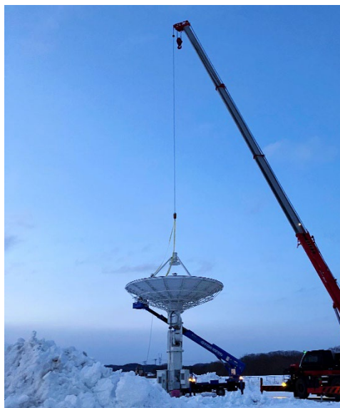
パラボラアンテナ施工状況
