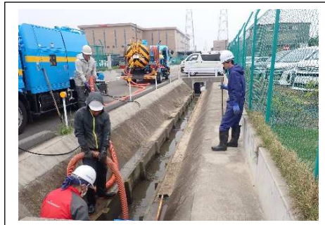
■ 岡崎工場: 用水路清掃風景 (2022年5月)
