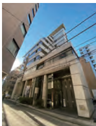
新橋フロンティアビル
