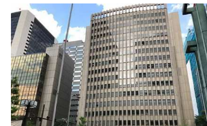
新橋カンファレンスセンター：2,813坪
