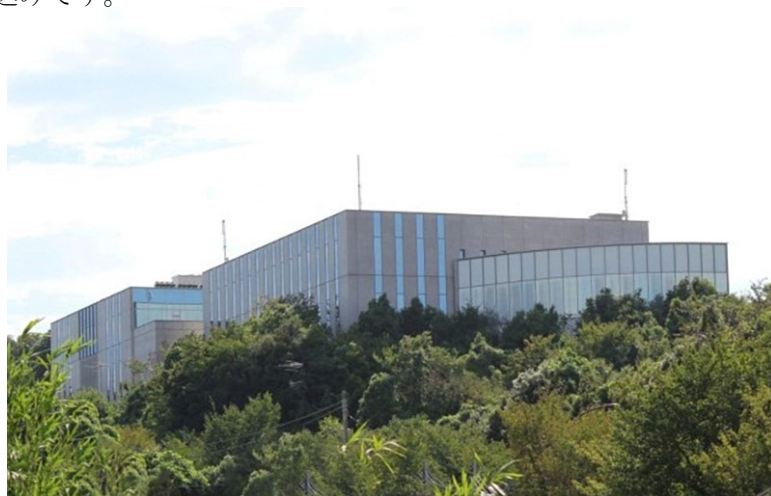
アイネット第1データセンター
