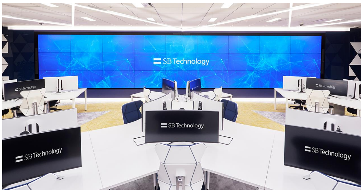
SBTのセキュリティ監視センター (SBT-SOC)
