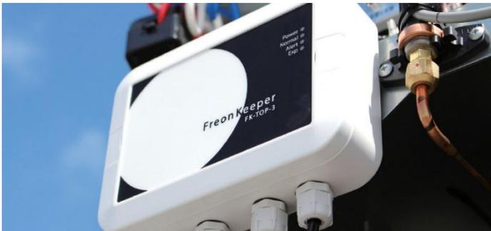
フロンキーパーとは、冷凍冷蔵設備をIoT化し、フロン漏洩の早期発見を可能とするシステムです。フロンの漏洩量を抑制することで環境への負荷を低減するとともに消費電力の削減にも繋がります。加えて、計測データをリアルタイムで把握することで機器の安定稼働や効率的な運用を実現します。
