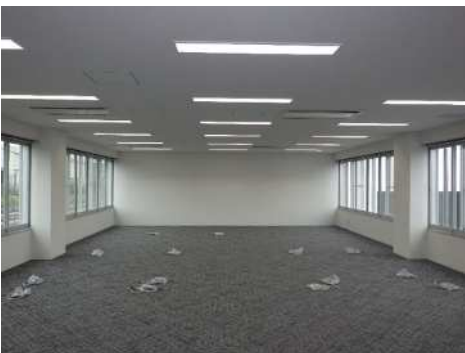
高効率 LED 照明機器の更新、明るさセンサー制御、スケジュール制御により無駄をカット
