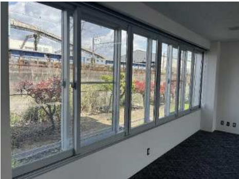
断熱改修+二重窓の設置により空調負荷を低減
