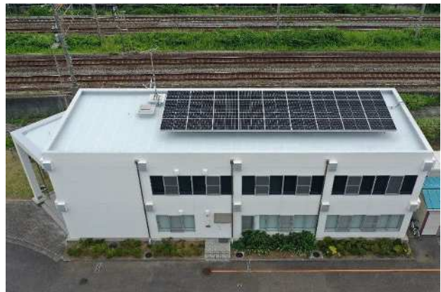
屋上に設置可能な最大範囲で太陽光パネルを設置
