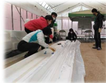
ベッドに、防水・給水・防根シートを張り、その上にバミスを敷き詰める
