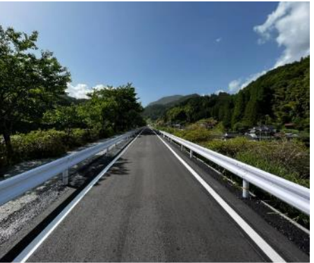
「ニュートラック」で舗装した JR九州BRT(バス高速輸送システム)専用道
