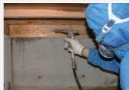
白蟻防除施工
