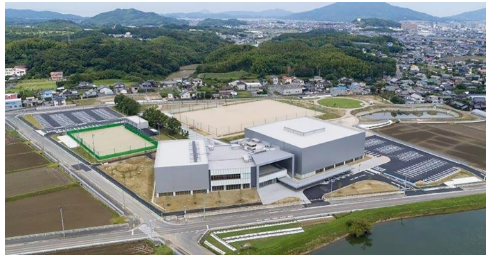
糸島市運動公園（手前建物が多目的体育館）
