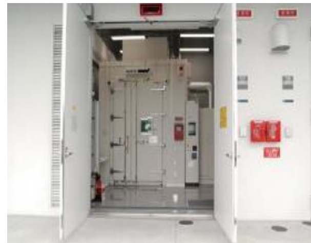
充放電試験用の恒温恒湿室
