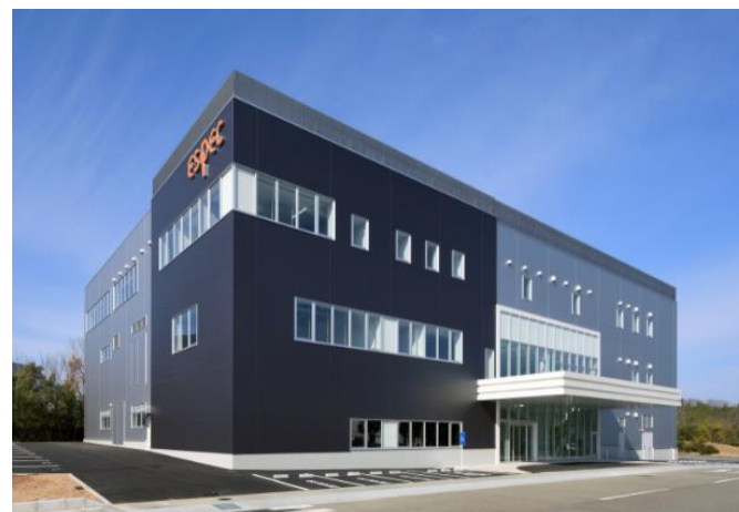
技術開発棟の外観
