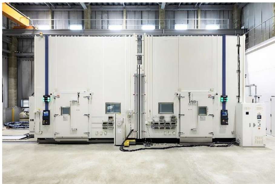
恒温(恒湿)室 建材用試験室
