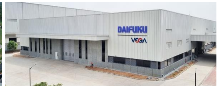
現在稼働中の工場（写真）とは別の地域に新工場を建設
