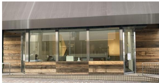
装飾パネル(本館1階南側入口)
