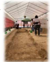
ベッドを設置する溝を掘り、地面を水平に整える
