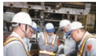
ローカルスタッフとの現場確認
