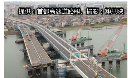
高速大師橋の橋桁一括架け替え工事の様子
