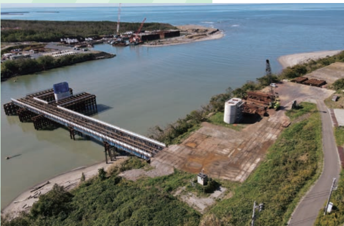
新野積橋橋脚
