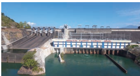
ナムグム第一水力発電所拡張 (ラオス)
