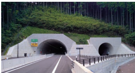
二重峠トンネル(阿蘇工区) (熊本県)
