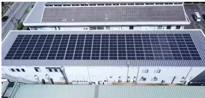
(屋上全面に太陽光パネルを設置)
