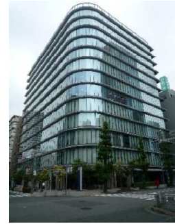
ORE 錦二丁目ビル
