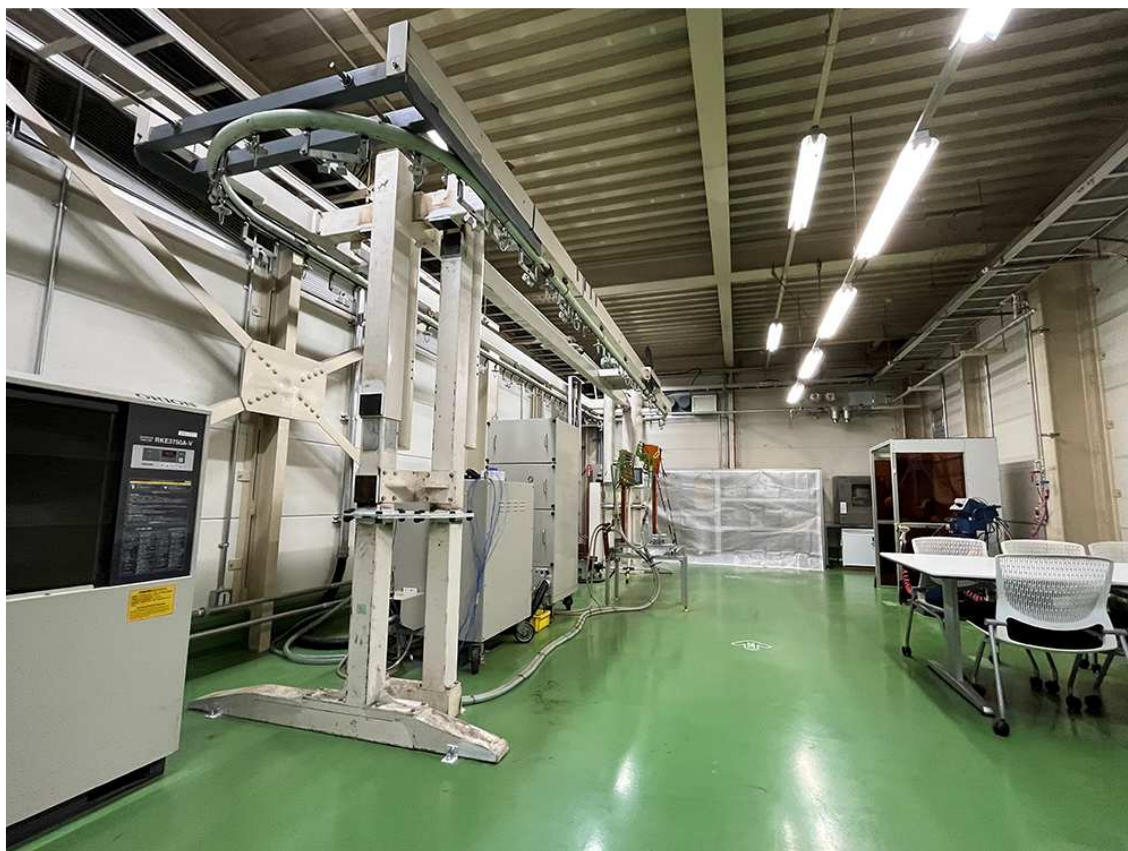
▲実証実験ラボ全体
