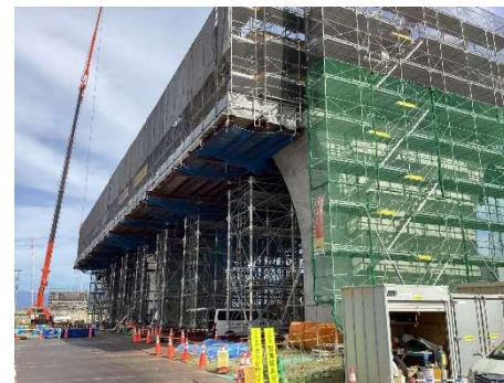
臼井阿原高架橋 (仮称) 上部工 (名古屋方)
