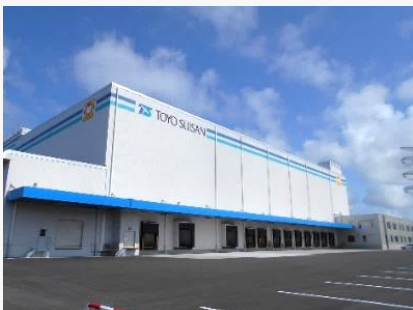
石狩新港物流センター
