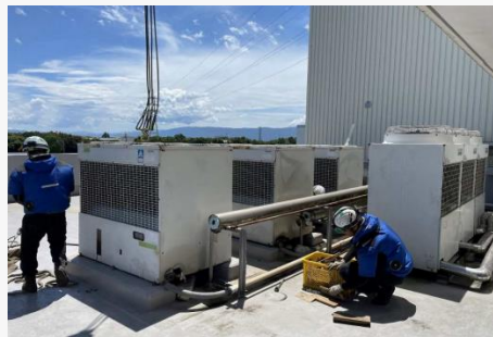
佐賀冷蔵庫フロン対策工事
