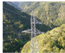
ユールス上勝神山(徳島県) (風力発電所[送電工事])
