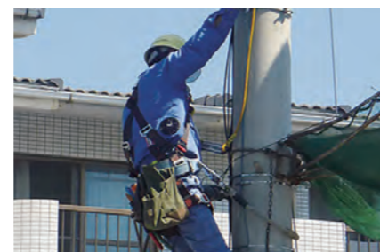
配電現場作業風景(空調服着用)
