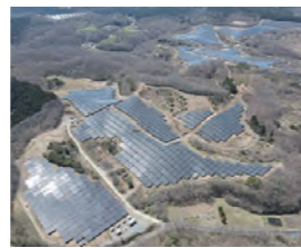
鮫川村青生野(福岡県) (太陽光発電所[建設工事])
