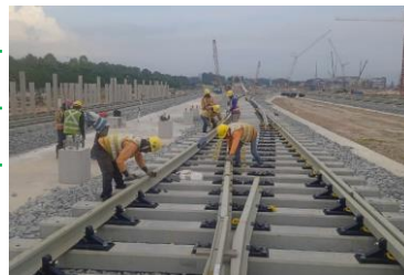
シンガポールにおける新線建設
