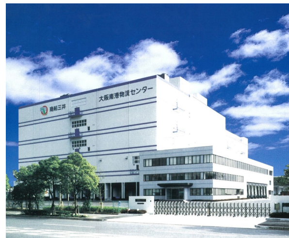
南港物流センター
