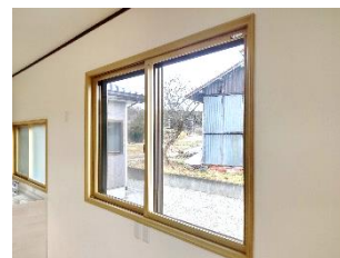
内窓の設置事例
