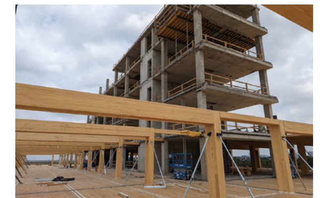
ガラス近郊木造オフィスビル建設現場(撮影日:2023年5月11日)
