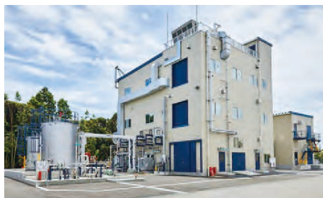
最先端レジスト用ポリマー製造設備 建屋外観
