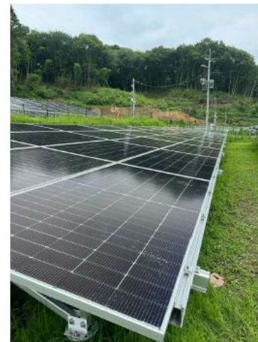
太陽光パネルの設置
