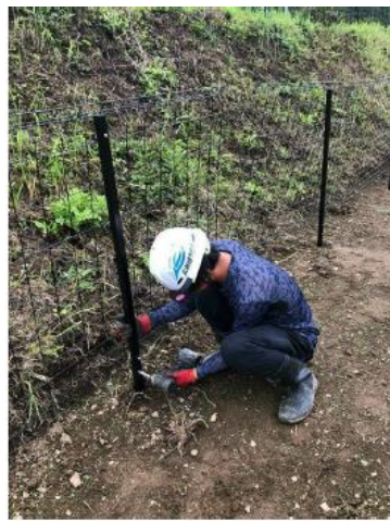
フェンスの設置や杭打ち等
