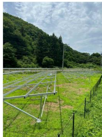
ケーブルや架台設置
