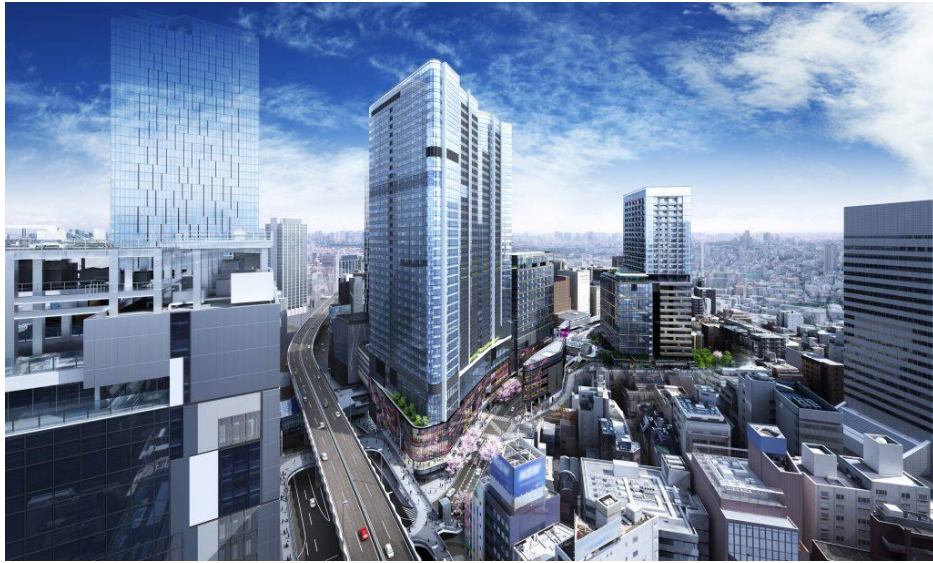
オフィス外観（画面中央）／出典：東急不動産
