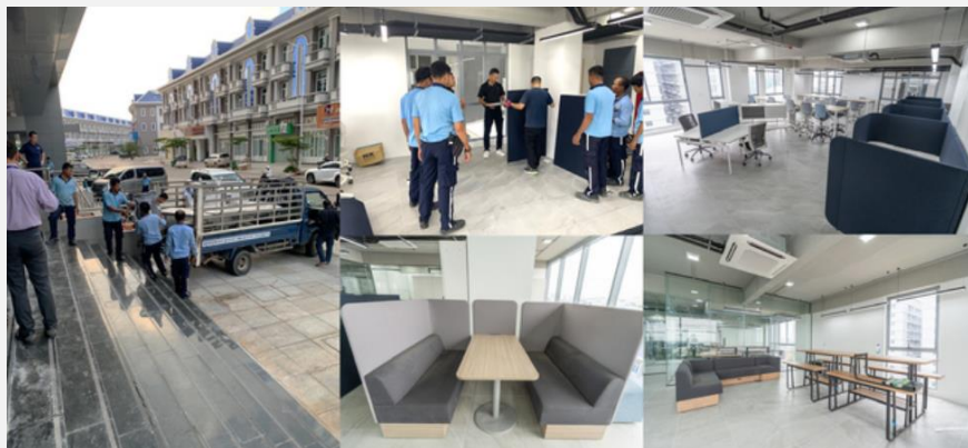
▲現地での搬入・施工スタッフ育成・什器設置後の様子
