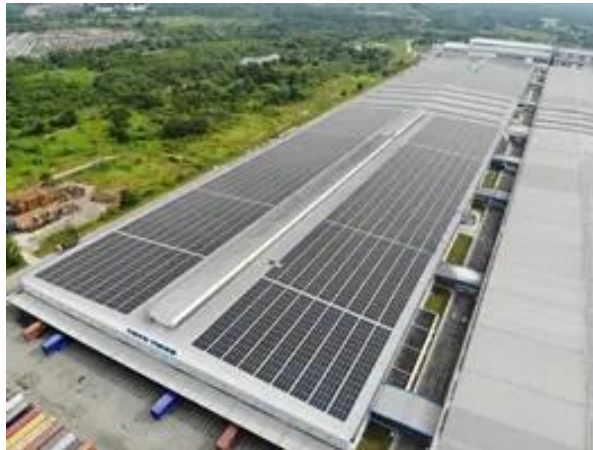
メガソーラーシステム
