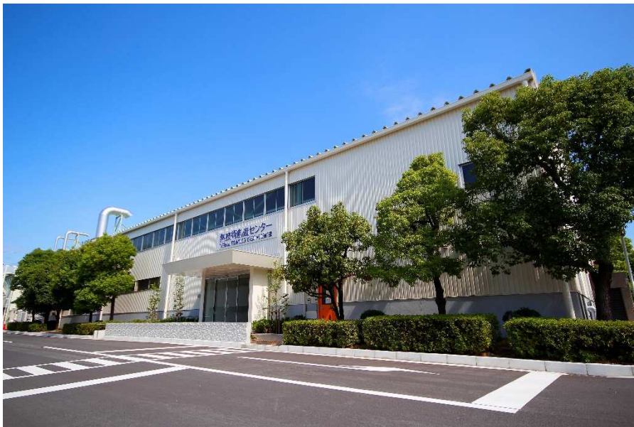
熱技術創造センター 外観
